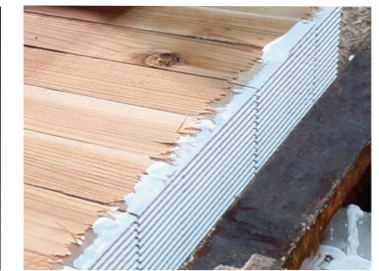
接着剤塗布後
