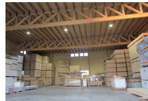
平行弦トラスによる 木造倉庫 (360m 2 ) (千葉県市原市)
