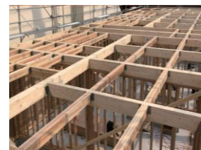
スギ4×材の床根太への活用
