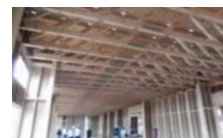
製材による大規模トラス
