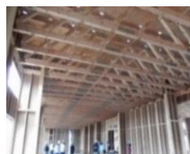
製材による大規模トラス
