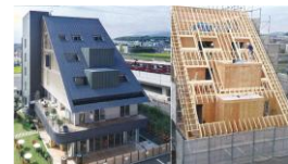
木造非住宅建築物 (※ J A S 構造材を活用した商業ビル)
